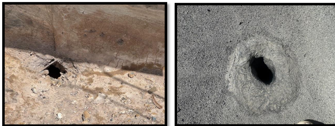
排水孔屋顶修缮后前后（对比）
