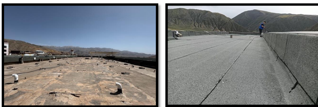
囊谦县一中学校屋顶修缮后前后（对比）
