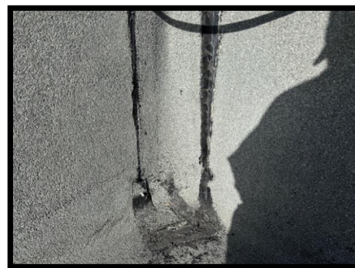
屋顶修缮后粉刷了涂料不在有漏水痕迹（对比）
